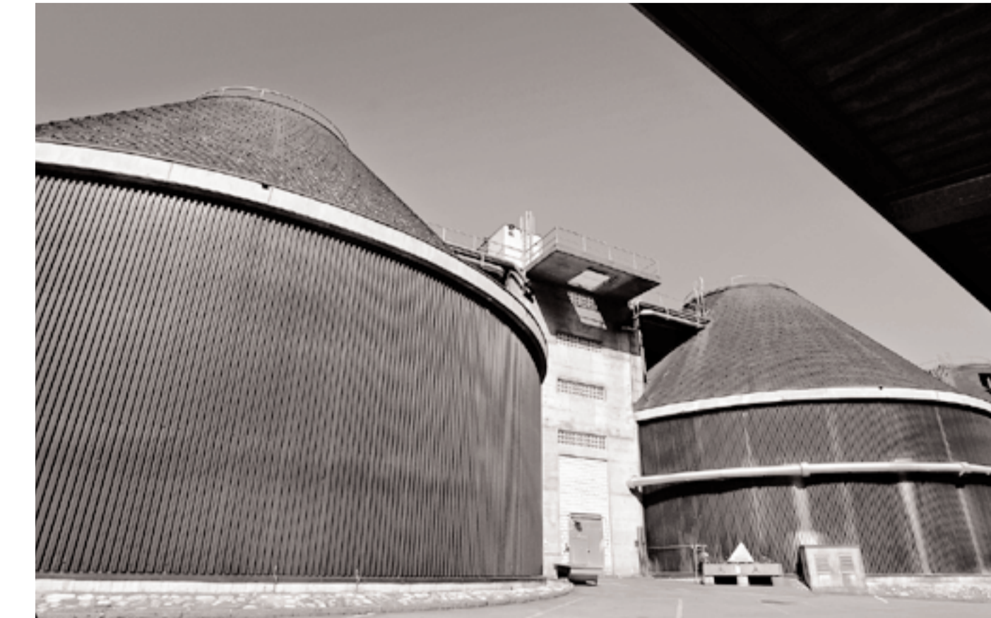
In diesen Faultürmen der ARA Region Bern entsteht das Biogas, mit welchem ab 2006 die Tanks der Gasbusse von Bern Mobil gefüllt werden.
